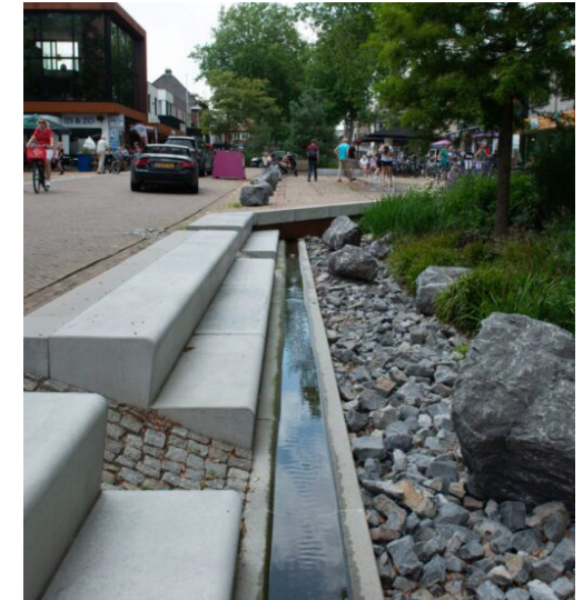
Zichtbaar water afvoeren naar een urban waterbuffer.
