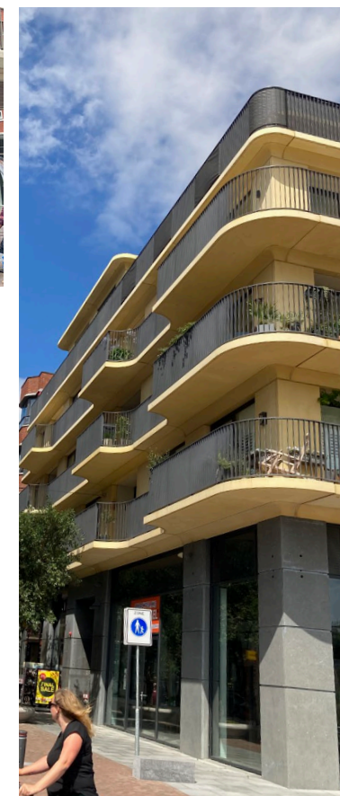
De overgang tussen het kleinschalige dorps hart en de kustzone wordt vormgegeven door de bovenste bouwlagen aan de dorpszijde van het plein terugliggend uit te voeren.
